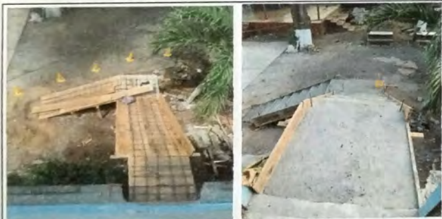
Foto 3: Vista de Conformacion de gradas, armado inicial, fundicion de gradas.
