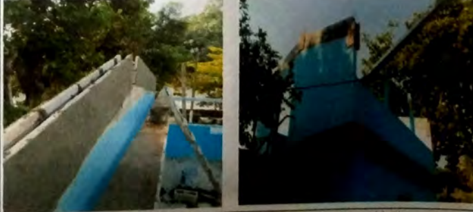
Foto 6: Vista de conformacion de solera mojitete en laterales, cubierta desmontada.
