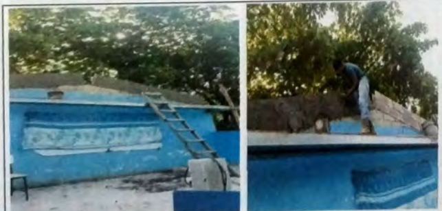
Foto 5: Vista de aula en 2do nivel, con desmontaje de cubierta existente y conformacion de solera perimetral para nuevo nivel de altura de cubierta nueva.
