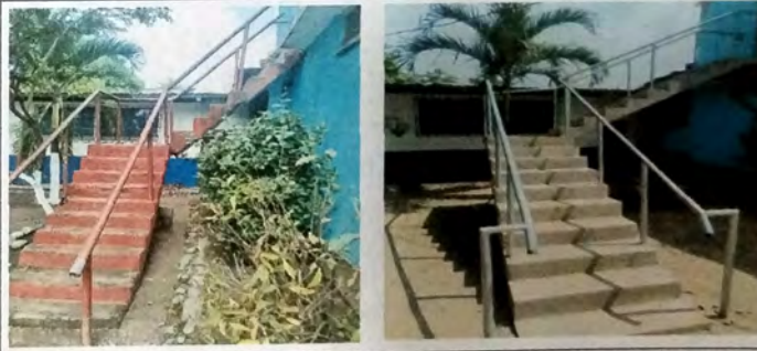
Foto 4: Vista de gradas existentes y Gradas de concreto nuevas con tubería h/g de 1 plg.
