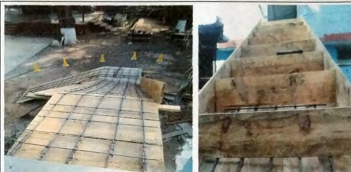
Foto 2: Vista de conformacion de gradas nuevas, sustituyendo la que estaban en malas condiciones.
